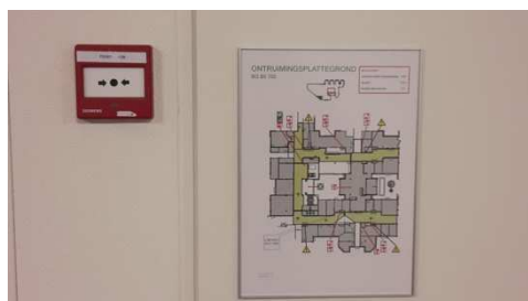
Afbeelding 3: handbrandmelder en vluchtroute
